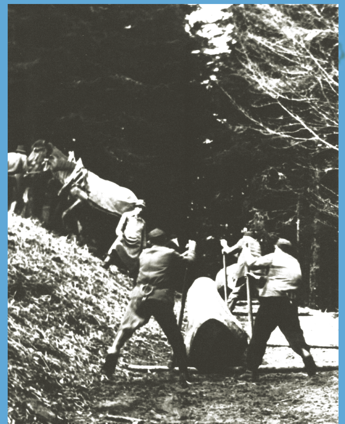
Holzhaupartie beim Krempenzug: nur gemeinsam konnten die Stämme mit einem Gewicht von bis zu sechs Tonnen bewegt werden.
