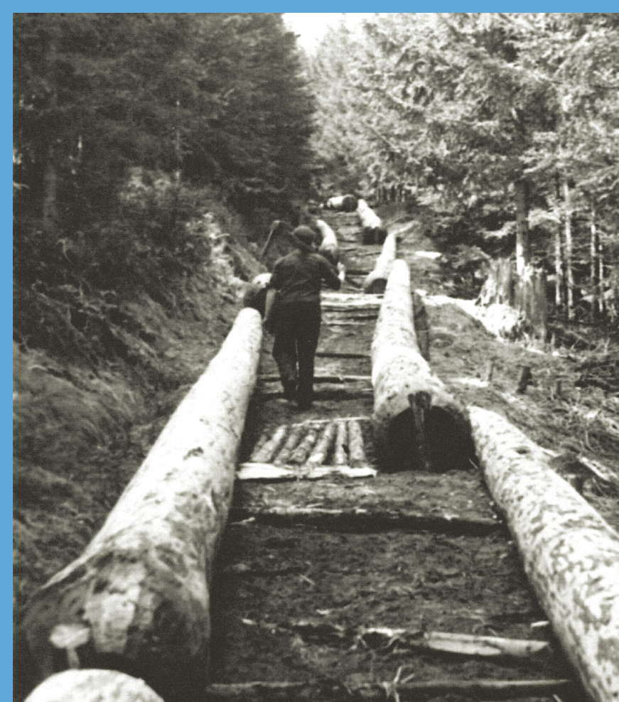
Rieshirte beim Kontroll- und Ausbesserungsgang. Schadhafte Quer- und Längshölzer mussten ersetzt werden.
